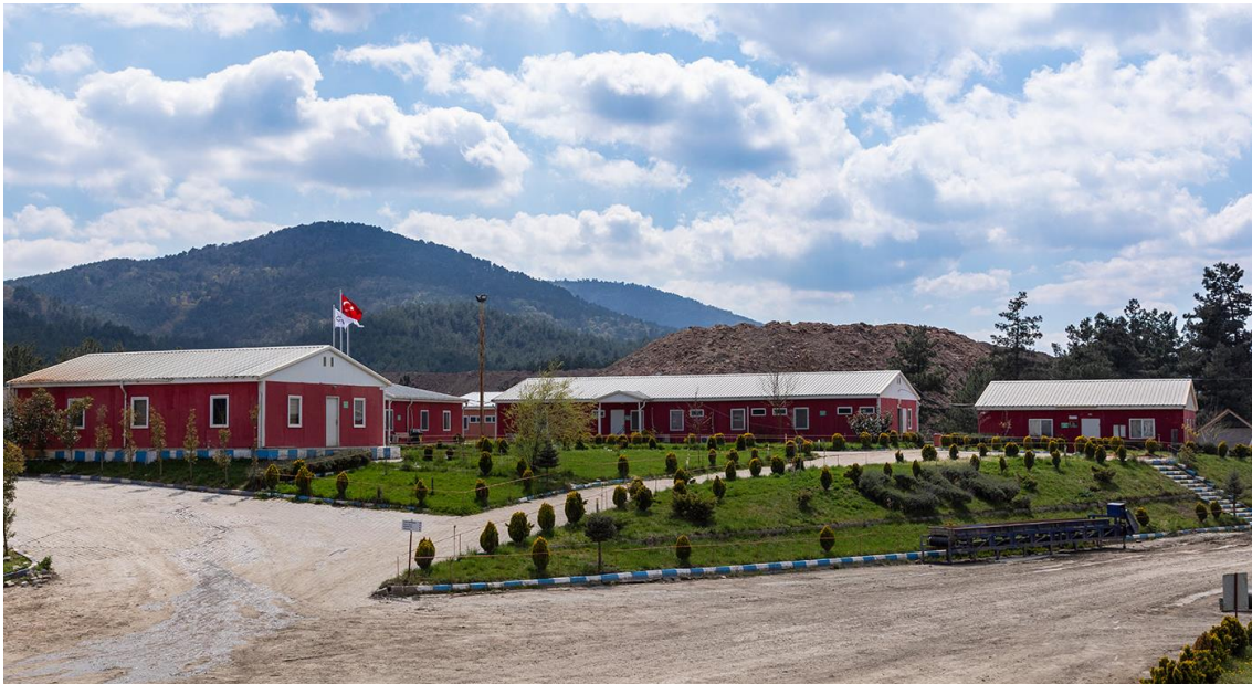
* Kalkım Kurşun-Çinko İşletmesi ve Flotasyon Tesisi
